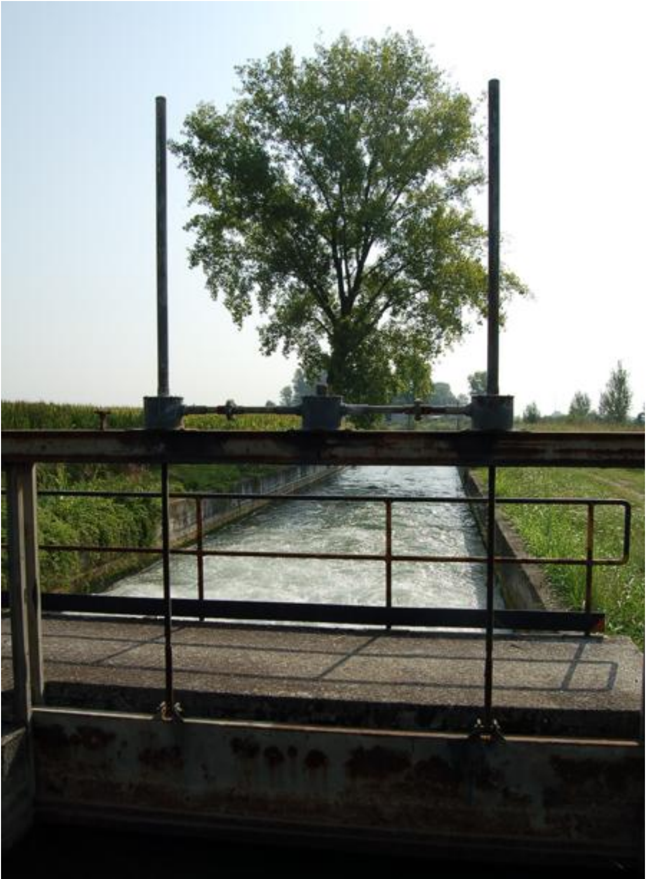
Bocca di presa del derivatore Cà de Bolli
